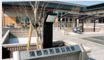
新形原公民館竣工 2月18日
